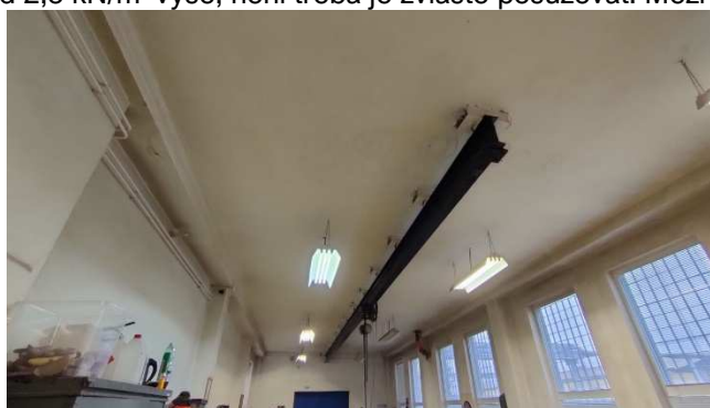
obr. 8 Jeřábová drážka na stropě nižší části
