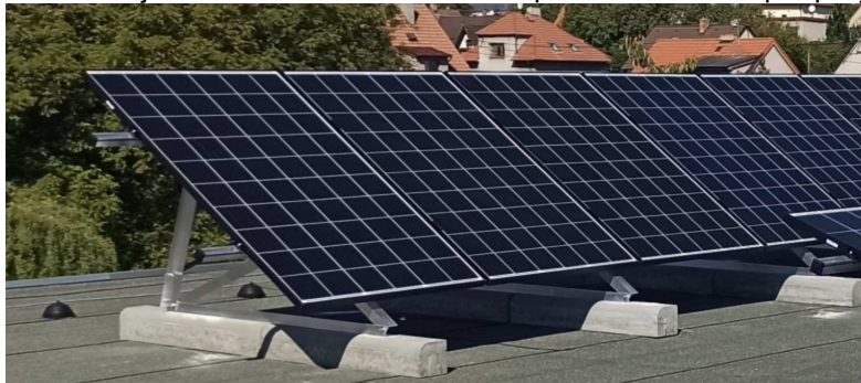
obr. 14 Příklad zátěže tvořené žb. prahy
